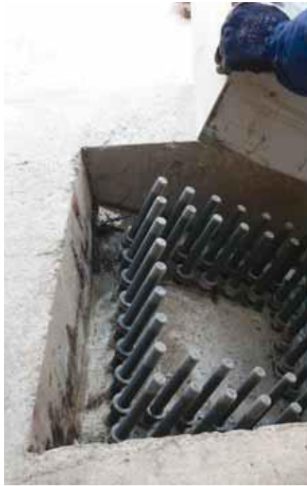
12. Voetplaat trekverankering vakwerk 1.1 (foto: de Nijs).
