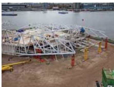
5. Fase 4 uitkraging westzijde na plaatsen gevelvakwerk 3.3 (foto: Moeskops).
