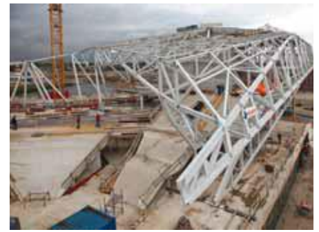
4. Eind fase 3, 'buitenconstructie' uitkraging oostzijde gereed (foto: Moeskops).
