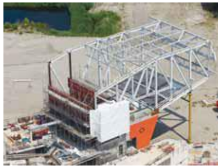
3. Eind fase 2, 'binnenconstructie' uitkraging oostzijde gereed (foto: Moeskops).
