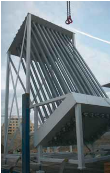
11. Ankers op hulpframe trekverankering vakwerk 1.1 (foto: de Nijs).
