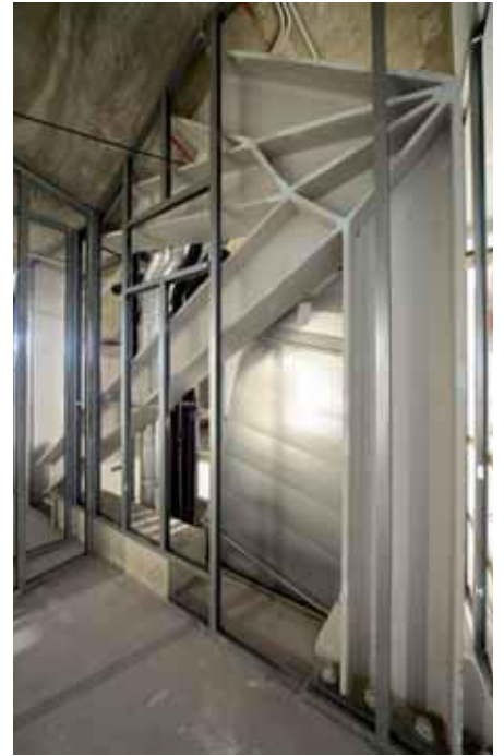
13. De staalconstructie wordt goeddeels aan het zicht onttrokken (foto: Erik Stekelenburg).
