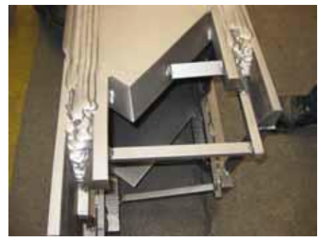
9. Vakwerk 1.1 in oostelijke uitkraging (boven). 10. Laswerk voor uit platen samengestelde kokers.
