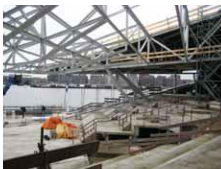
6. Fase 5, koppelen bouwdeelen en sluiten dak.
