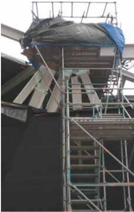
7b. Steiger voor gelaste knoop vakwerk 1.4 en 3.3.
